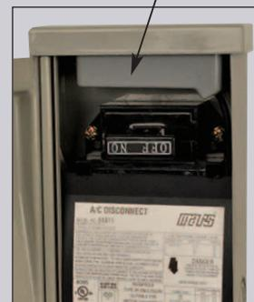
Módulo de sobretensión (Insertado) Montado dentro de la caja de desconexión
